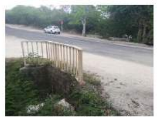
PR 4+900, ouvrage hydraulique
