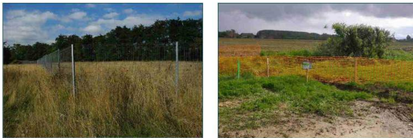
Figure 126 : Différents types de balisages de zones sensibles en bordure des emprises à mettre en place avant les travaux
