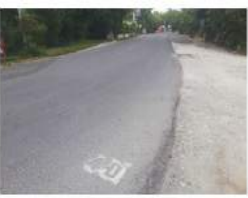
Marquage PR dans le virage
