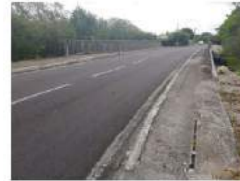
Pont sur la ravine Kabouanne, vue en direction de la Pointe-des-Châteaux
