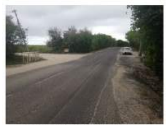
PR 4+900, ouvrage hydraulique et intersection
